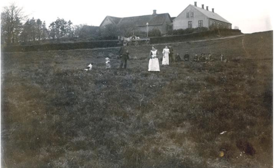
Fattiggaarden 1907, gården brændte 7/7 1897 efter lynnedslag og blev genopført som på billedet. Her var Fattiggård fra 1881 - 1/4 1946 for Funder - Engesvang - Kragelund kommune
